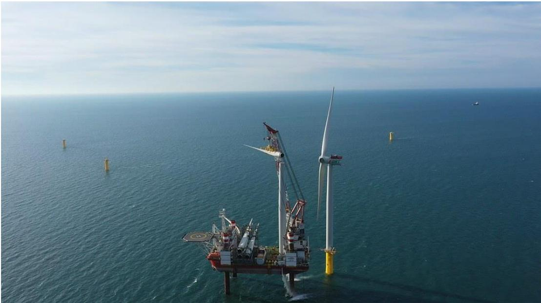
施工船以四隻腳固定在海床上，形成一個施工平台。圖片來源：海洋風電
